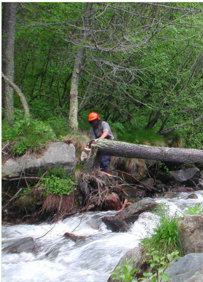
FIGURA 11: Taglio della vegetazione in alveo.
