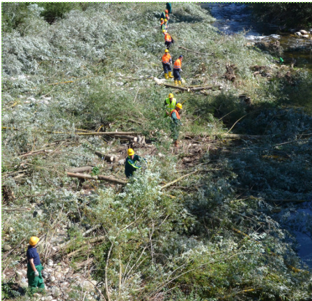
FIGURA 13: Taglio vegetazione in alveo.
