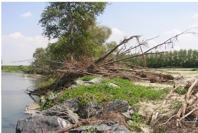
FIGURA 1: Esempio di vegetazione asportata, fuitata dalla corrente e depositata lungo la sponda.
